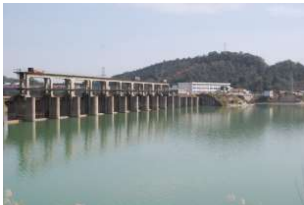
图 2.7-2 青山水轮泵站现状
