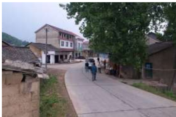
路基宽度不足
